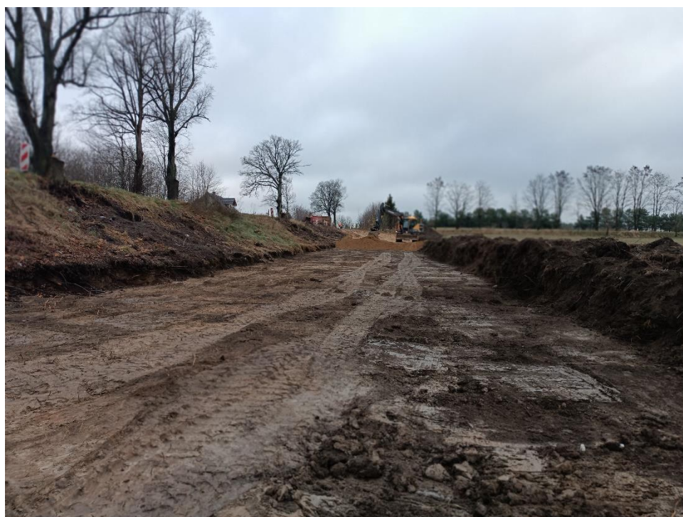
Km drogi ok. 32+770 (budowa objazdu)
