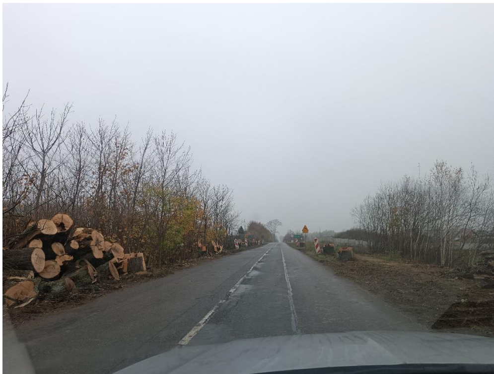
Km drogi ok.29+500 (wycinka drzew)
