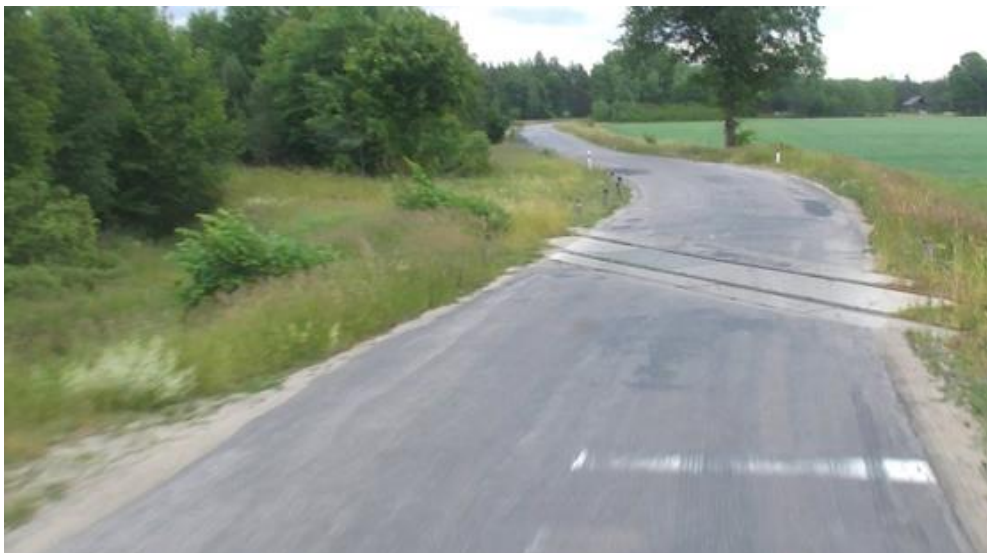
Przykład 9: Przejazd przez tory kolejowe
