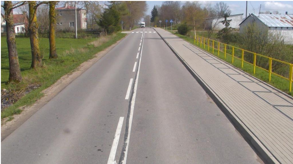
Przykład 3: Skrajne prawe odczyty obejmują krawężnik znajdujący się przy krawędzi jezdni
