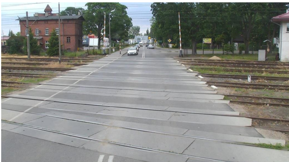
Przykład 10: Przejazd przez tory kolejowe
