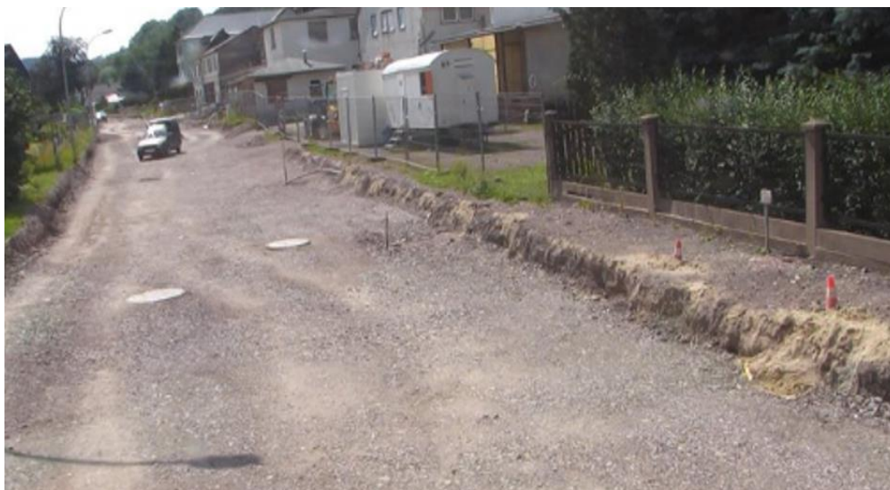
Przykład 20: Przebudowa drogi
