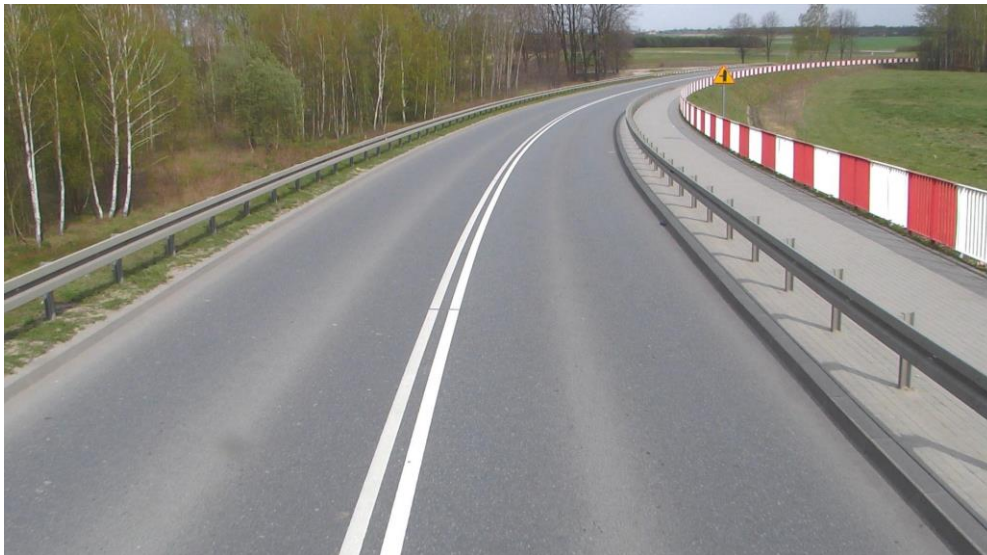
Przykład 7: Skrajne prawe odczyty skanera laserowego odbijają się od bariery znajdującej się przy krawędzi jezdni
